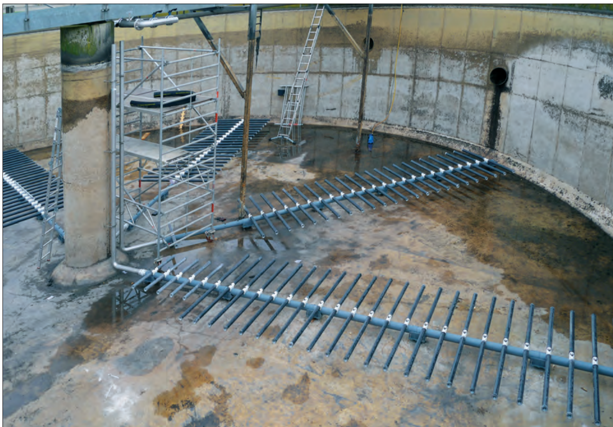
Un système de conduites tubulaires AirRex® avec aérateurs MAGNUM® Flexnorm dans un bassin rond en Allemagne du Nord.
